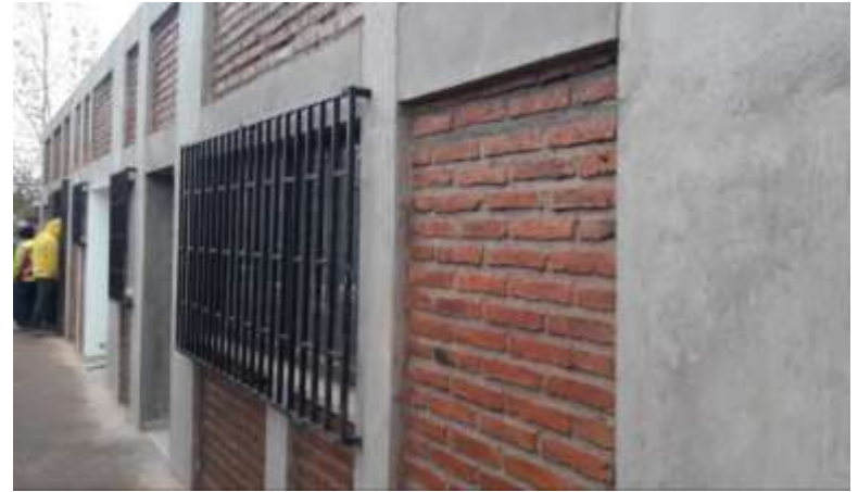
10 Construcción nueva porteria, SSHH y oficinas Ejecución de Obras
