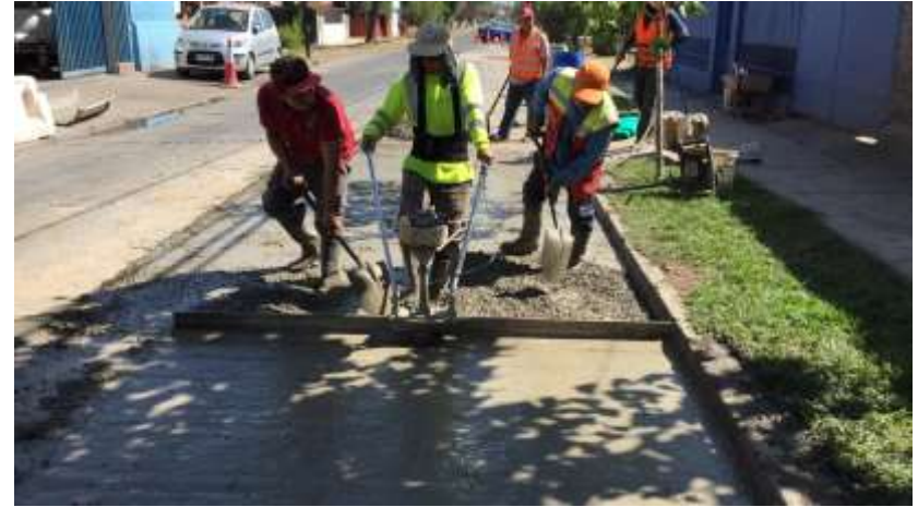
2 Construcción Calzada Calle Eleuterio Ramirez
