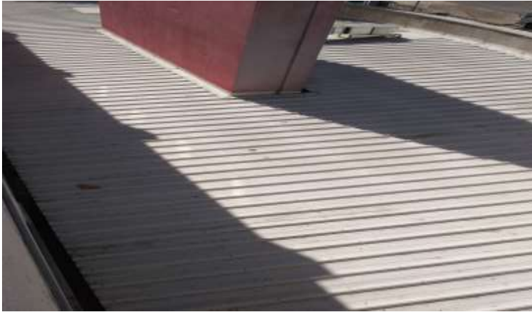
5 Cubierta Centro Cívico
