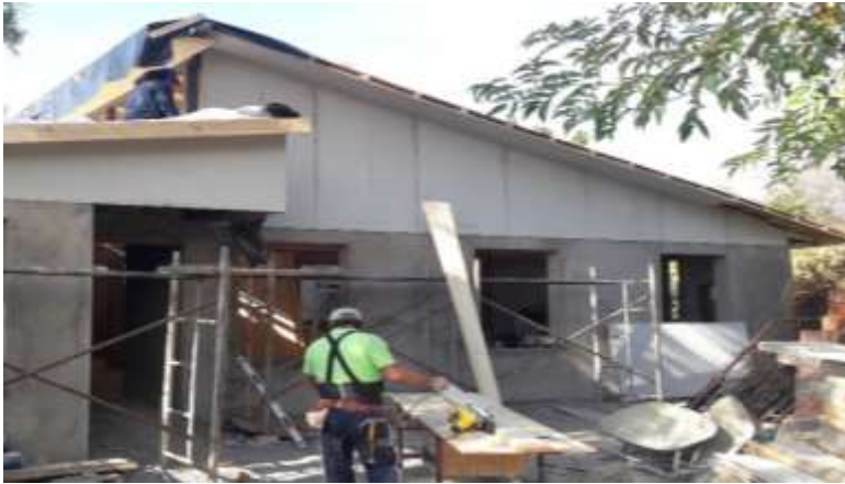
5 Mejoramiento Sede Social Villa Santa Cristina
