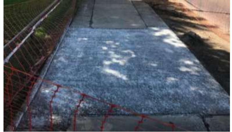
6 Tramo Emergencia vial Gran Avenida
