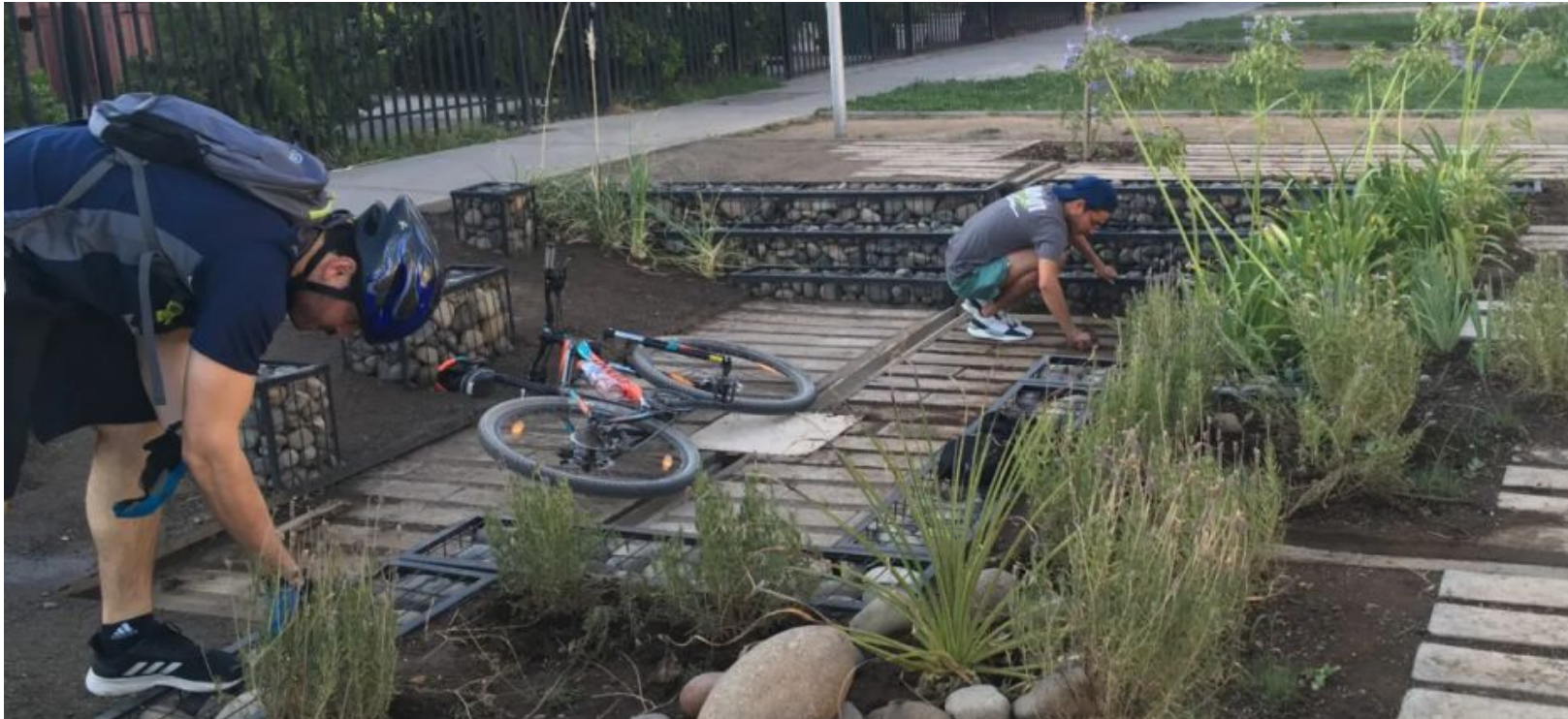
Proceso de construcción Fuente: Aguas de Barrio
