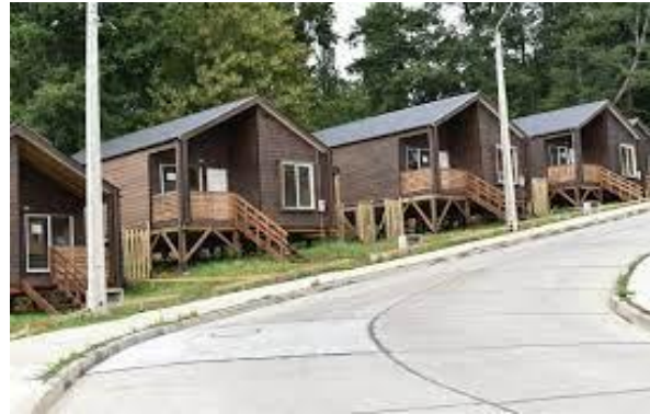
Construcción Conjunto Habitacional
